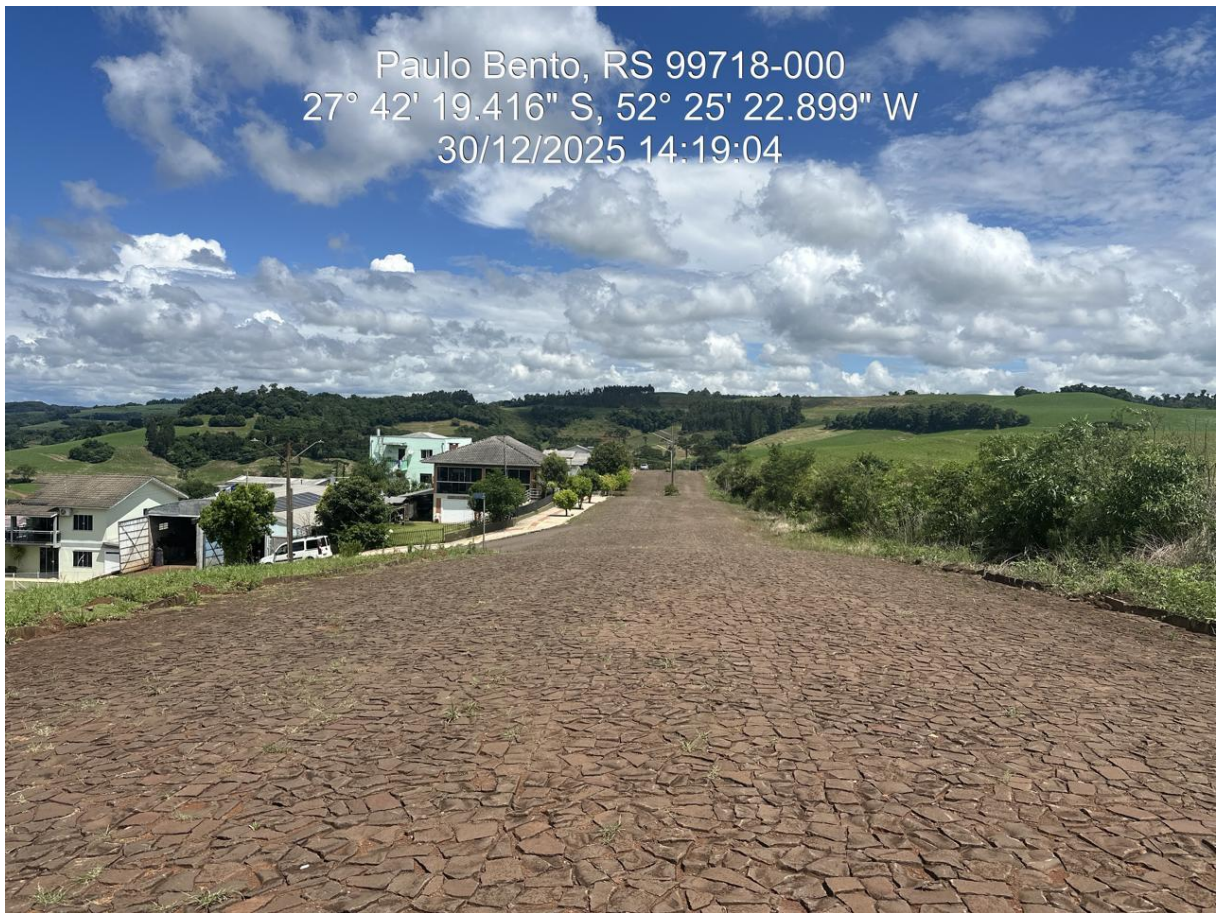
Foto 02: Ponto Intermediário do Trecho – Rua São Paulo – Sentido Sul
