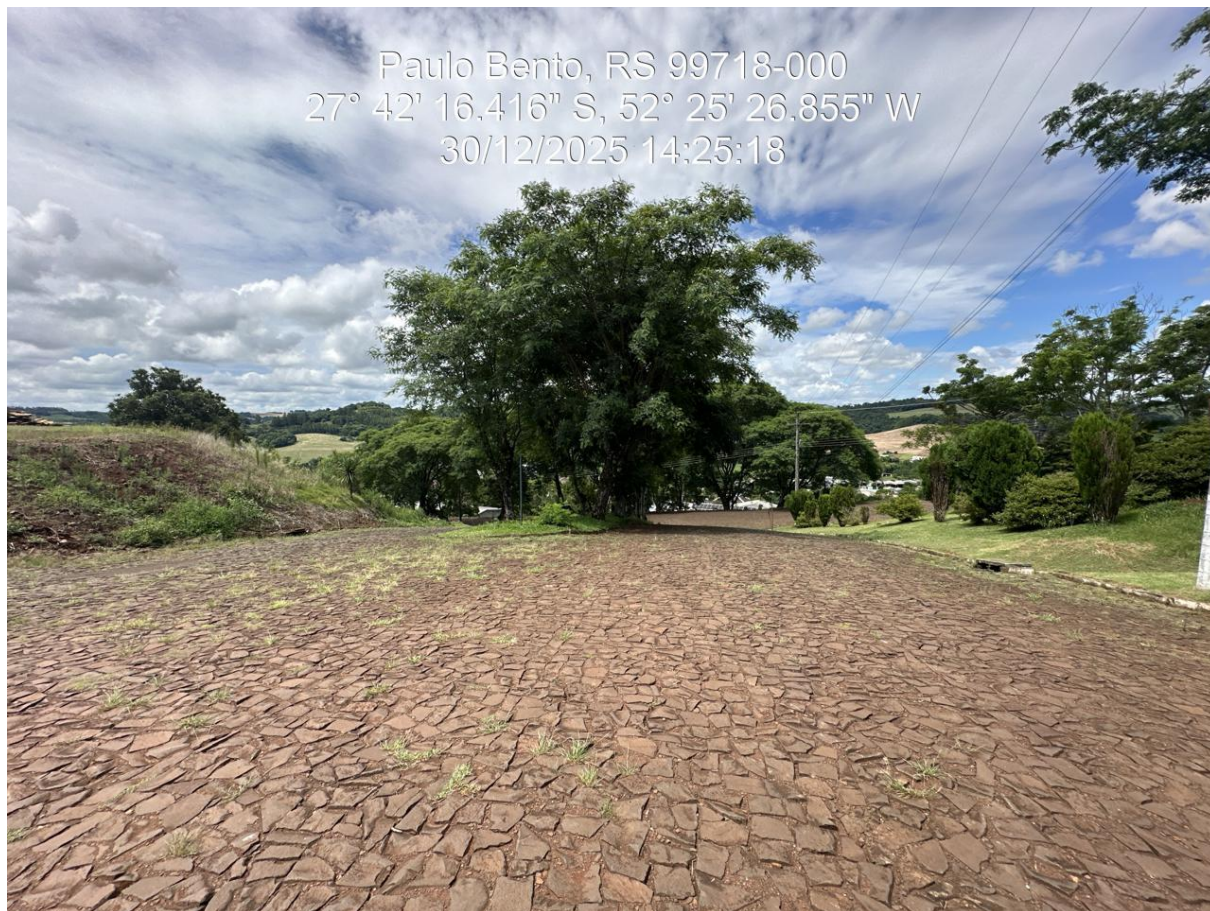
Foto 06: Ponto Intermediário do Trecho – Rua Valdomiro Schillo – Sentido Leste
