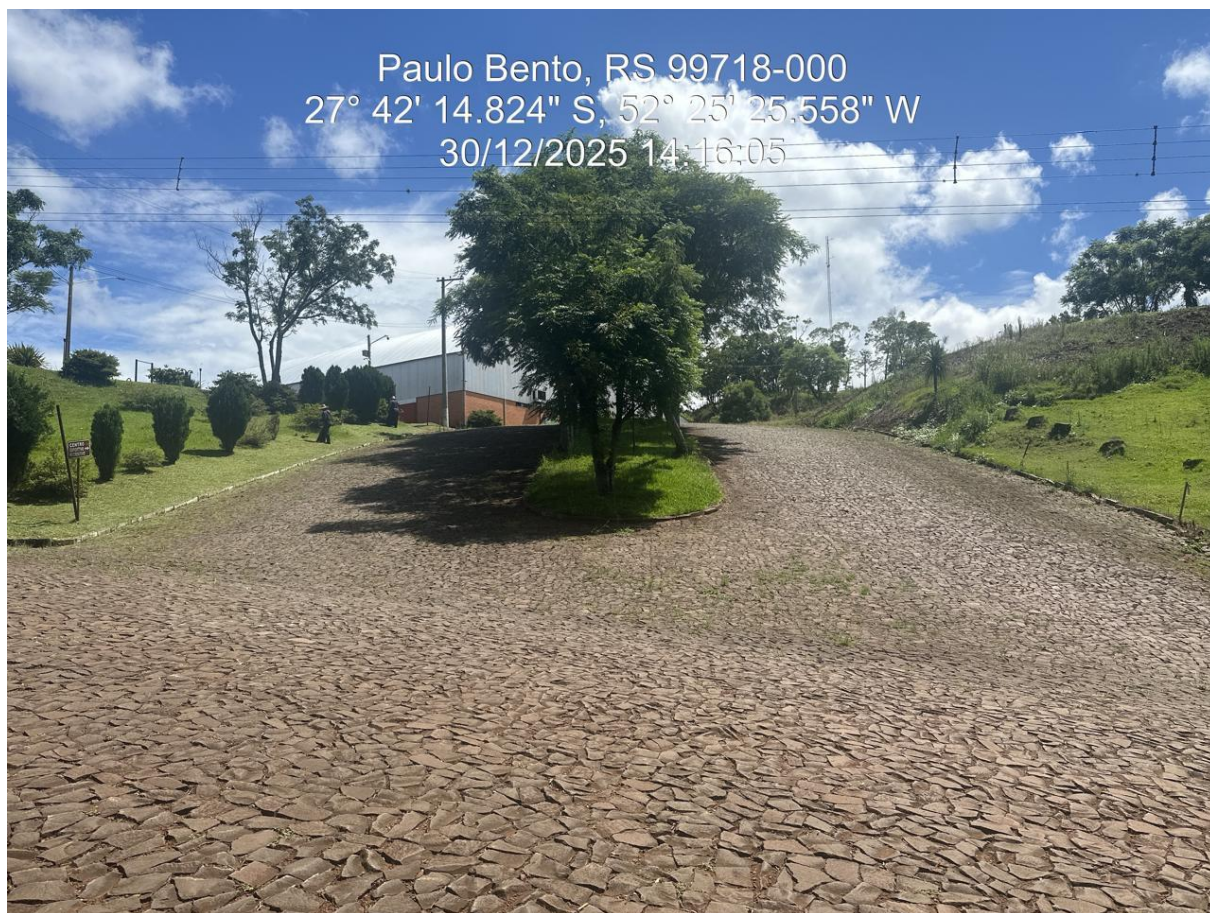
Foto 05: Ponto Inicial do Trecho – Rua Valdomiro Schillo – Sentido Oeste
