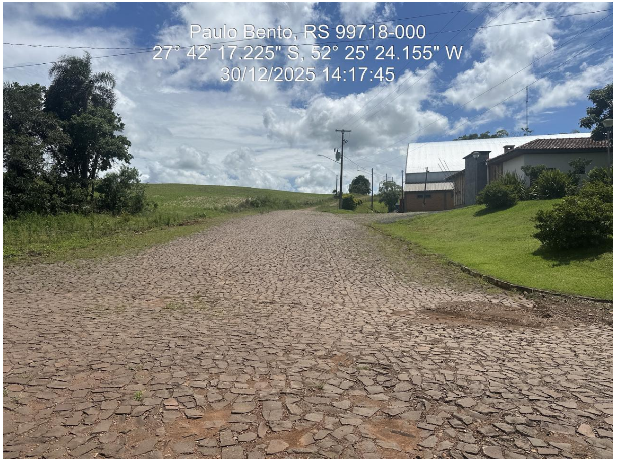
Foto 15: Ponto Inicial do Trecho – Rua Silva Jardim – Sentido Oeste
